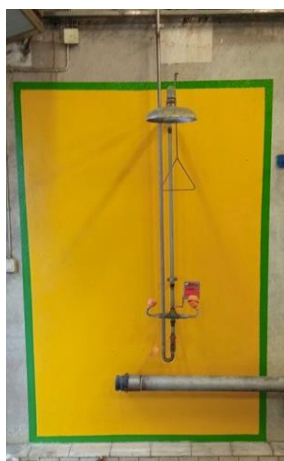
Bilde: Eksempel på nøddusj i tynnsyrestasjonen og på laboratoriet.
