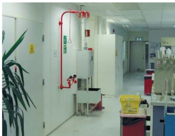
Bilde: Eksempel på nøddusj i tynnsyrestasjonen og på laboratoriet.
